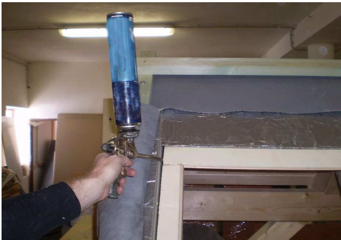
Obr. 09 - Vyplnenie škár montážnou penou
