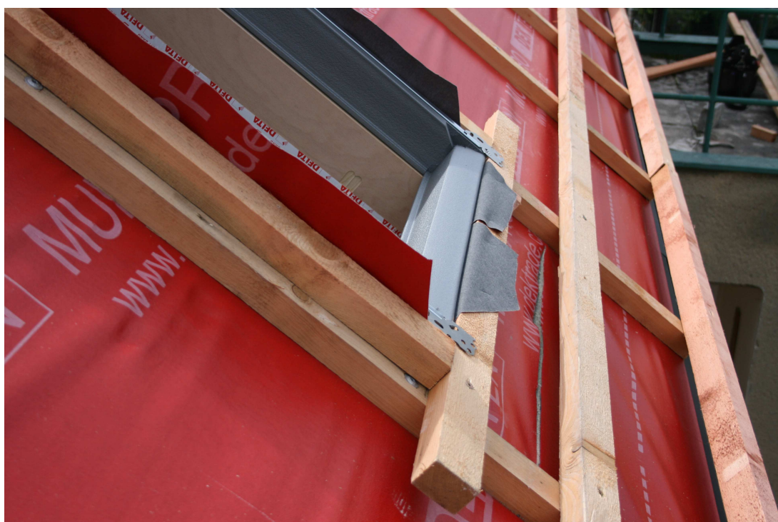
Obr. 10 - Ukončenie poistnej hydroizolačnej vrstvy na latách
