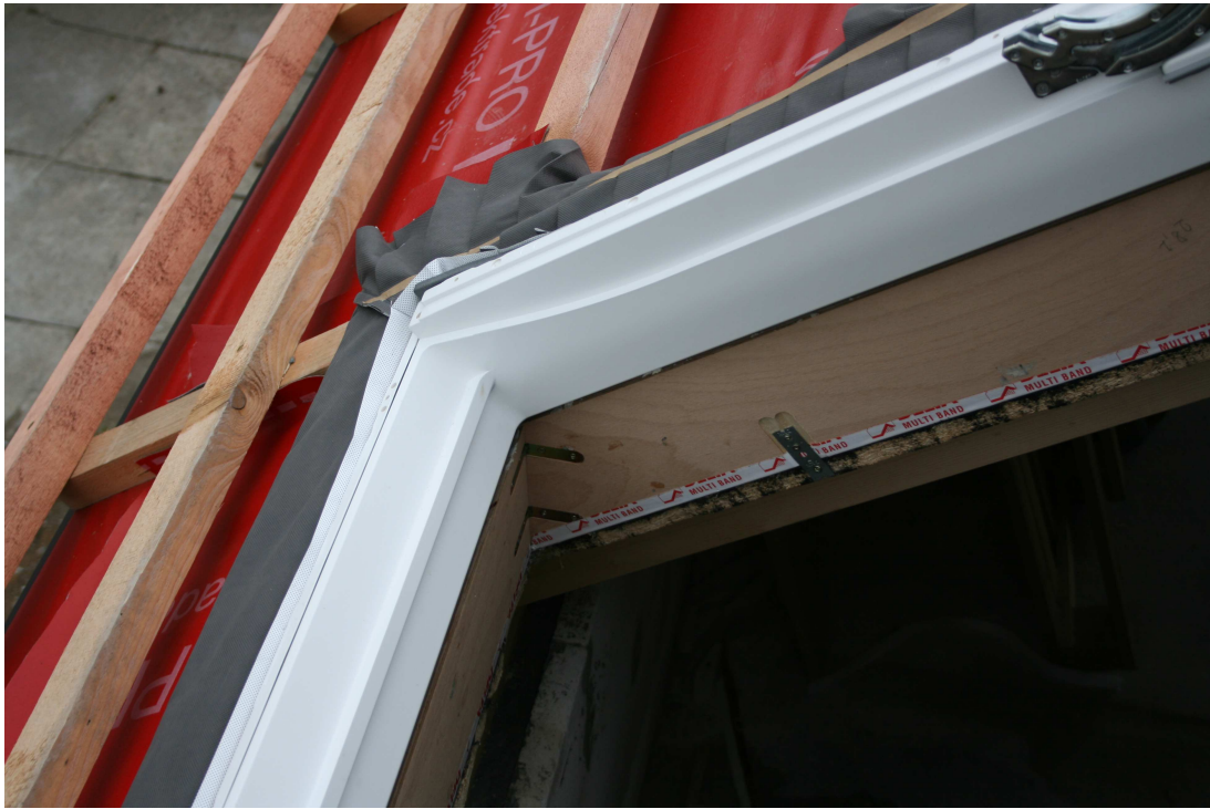
Obr. 11 - Osadenie strešného okna na montážne laty
