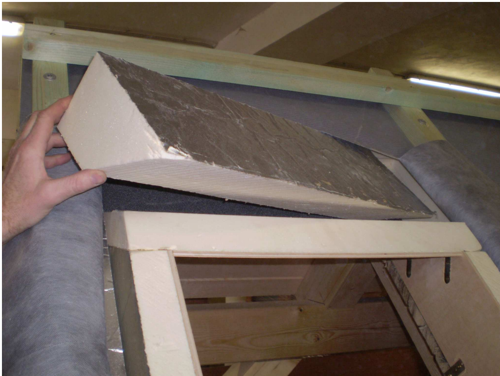
Obr. 08 - Doplnenie tepelnej izolácie (diely šablóny z PIR)
