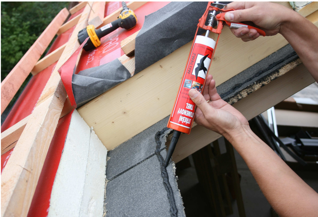
Obr. 06 - Nanesenie tmelu na okraj debnenia
