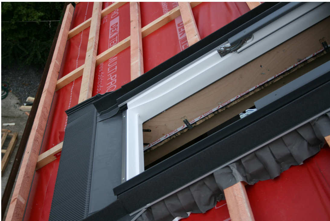
Obr. 12. - Montáž lemovania
