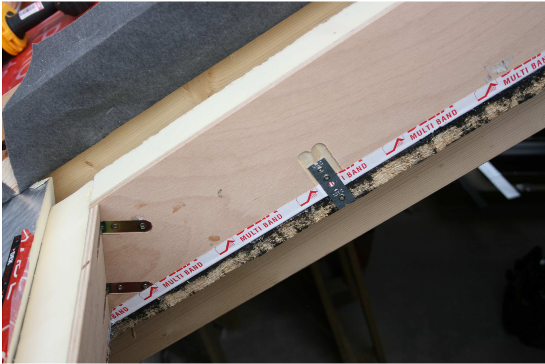
Obr. 07 - Upevnenie dielca k debneniu
