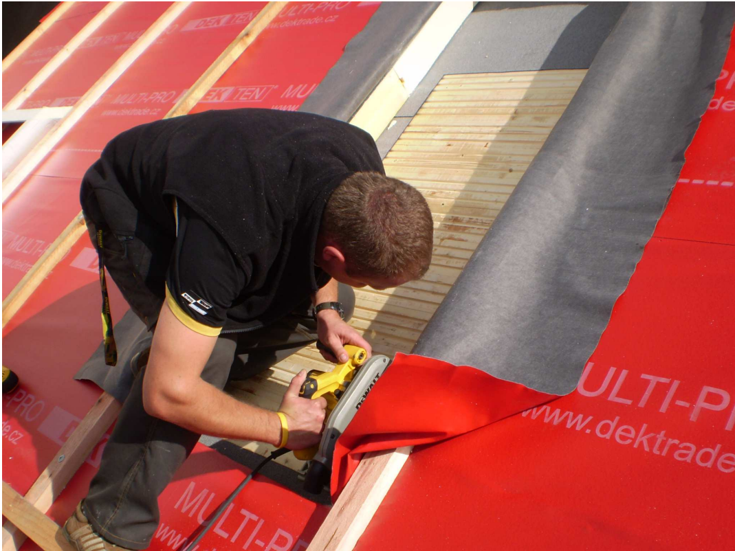
Obr. 05 - Vyrezanie otvoru v debnení
