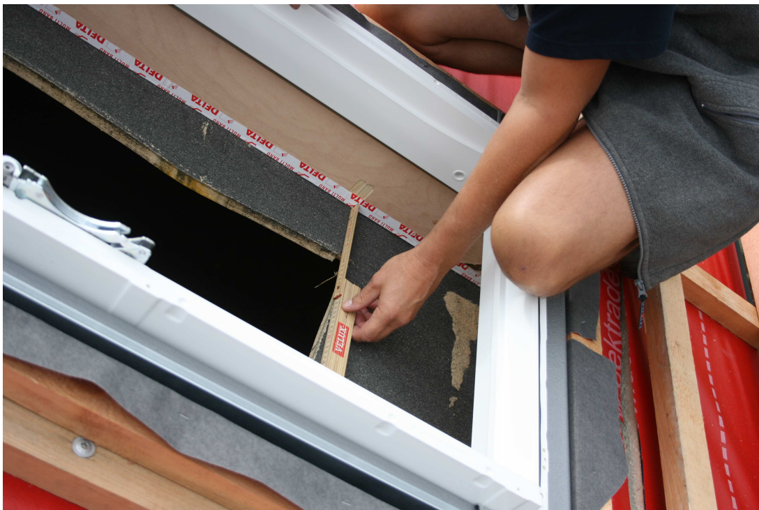
Obr. 03 - Rozmeranie polohy okenného dielca
