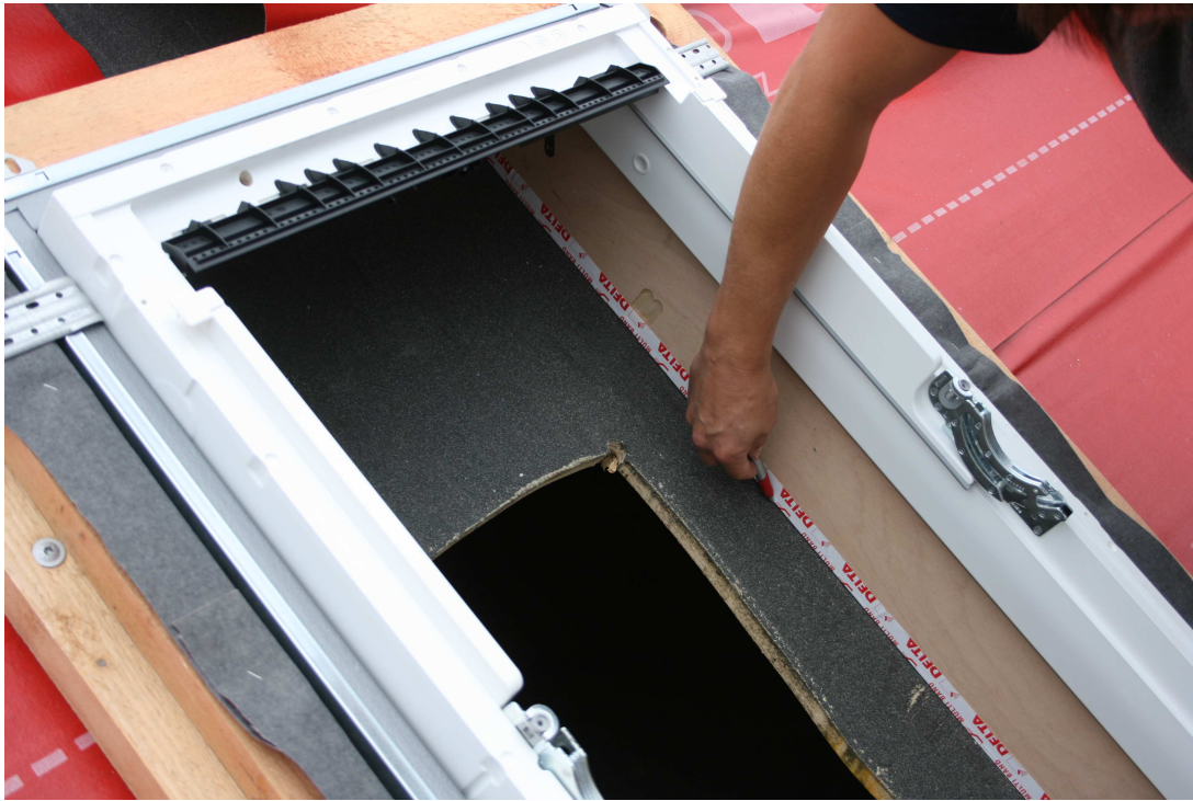
Obr. 04 - Obkreslenie línie rezu otvoru v debnení
