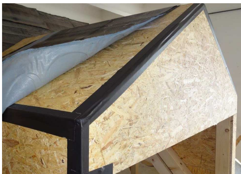
Obr. 30 - Prelepenie škár opláštenia konštrukcie vikiera
