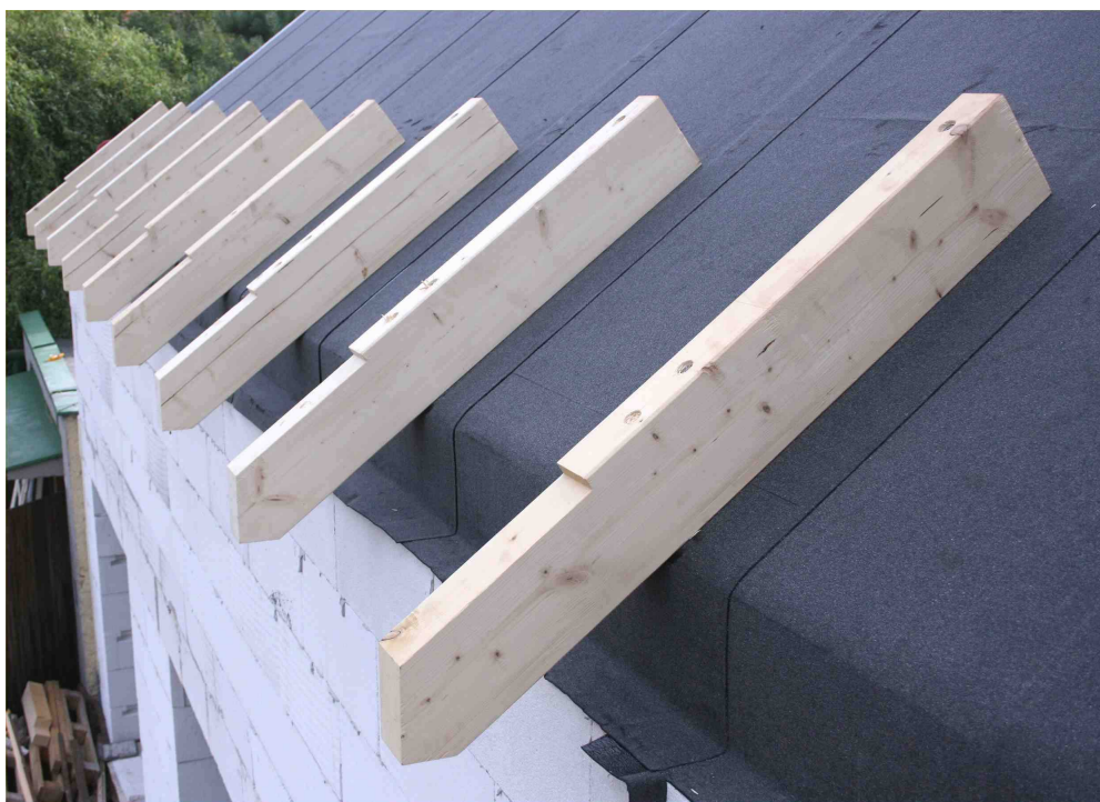
Obr. 7 - Upevnenie podpier presahu strechy pri odkvape
