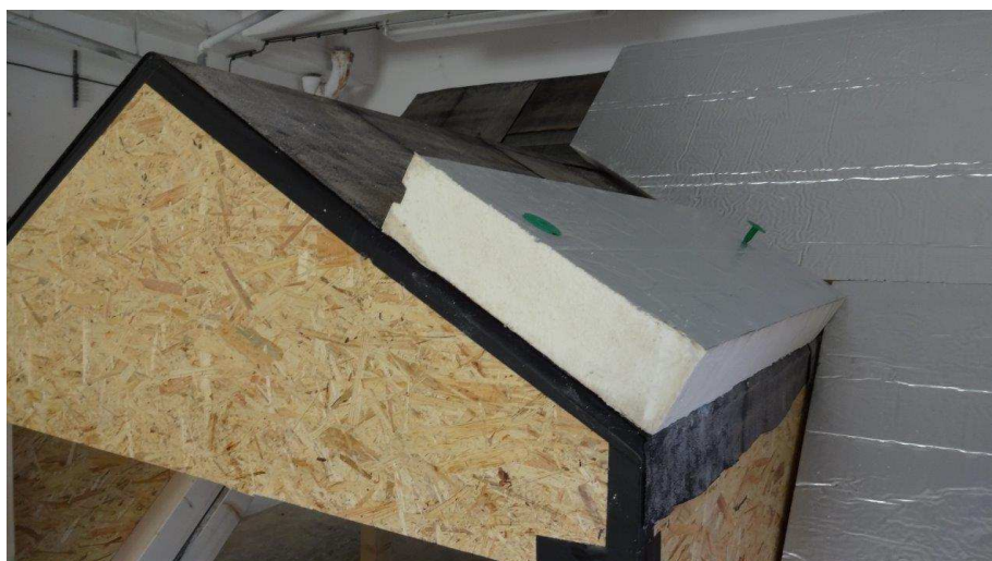
Obr. 31 - Pracovné upevnenie tepelnoizolačnej vrstvy pri odkvapovej hrane
