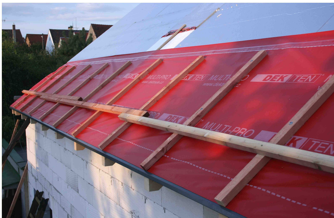
Obr. 12 - Pokládka poistnej hydroizolačnej vrstvy
