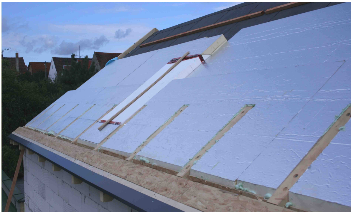
Obr. 9 - Ukončenie tepelnoizolačnej vrstvy pri odkvape
