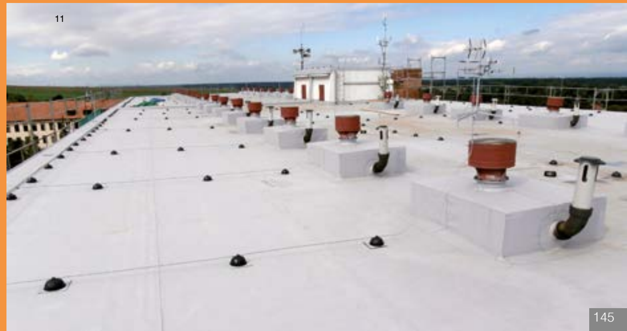
11| Strecha po rekonštrukcii.
