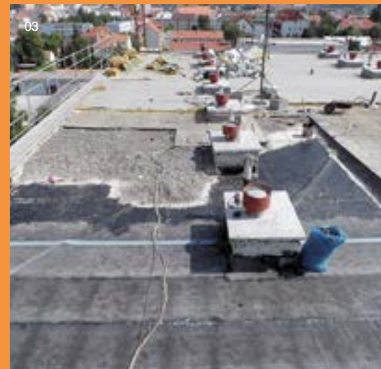
03, 04 | Etapové odstraňovanie pôvodných vrstiev skladby až na ŽB panel.
