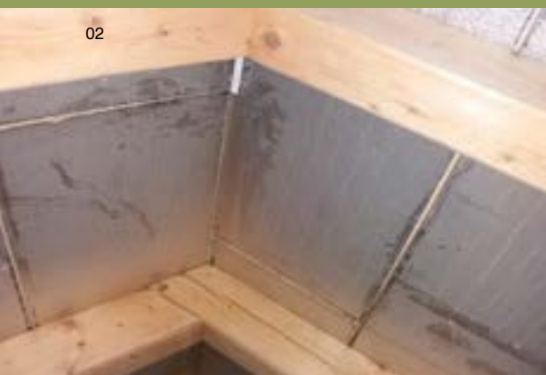
02–04| Rozšírené škáry medzi PIR doskami, na okrajoch dosiek viditeľné stopy po páskach.
