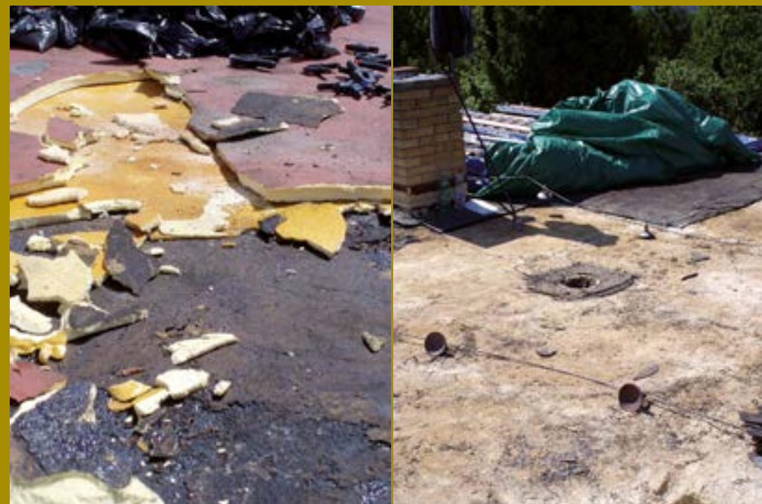
04| Odstránenie PUR nástreku.
