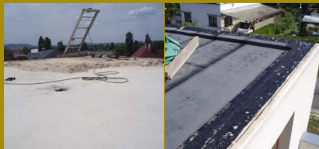
06| Odstránenie pieskového násypu.
