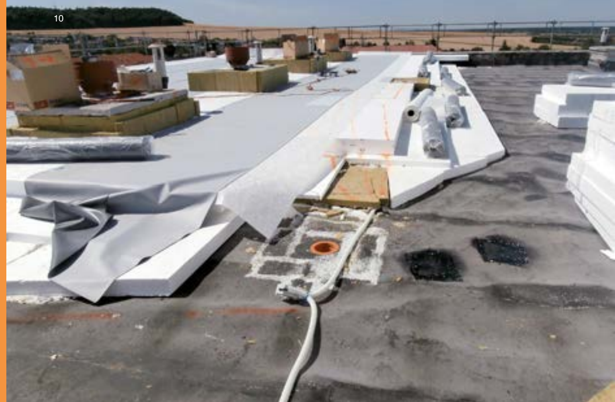
10| Prekresľovanie polohy káblov na podkladnej vrstve kvôli kotveniu povlakovej hydroizolácie.
