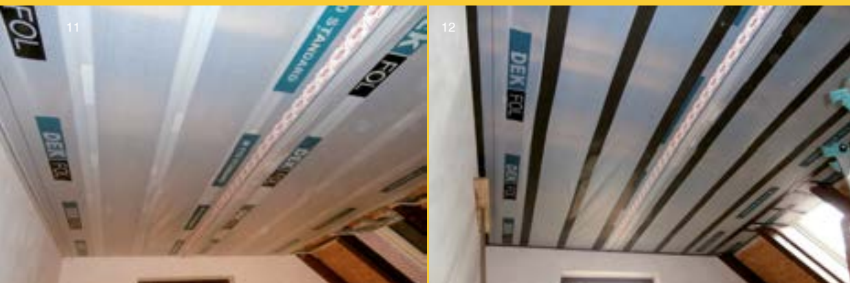
12| Pohľad na PE fóliu pred kotvením sadrokartónových dosiek (meranie B).
