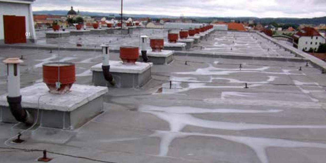
01 | Strecha pred rekonštrukciou.
