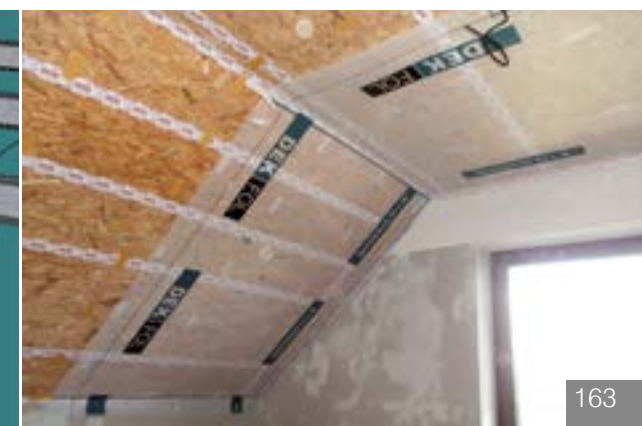
02 | Realizácia parozábrany z PE fólie – 2. fáza merania (meranie B).
