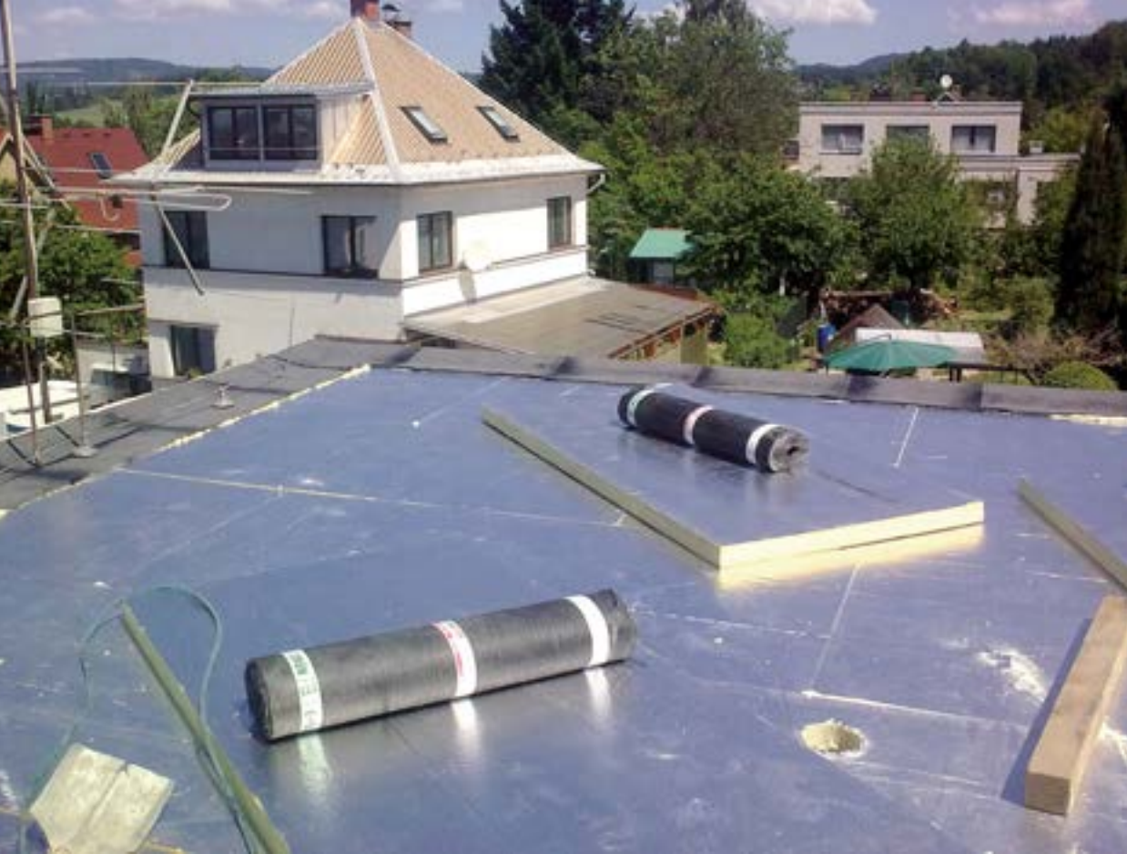
08| Pokládka PIR dosiek.
