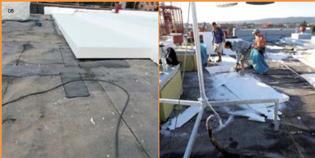
08, 09| Vyrovnávanie podkladu upravenými doskami z EPS 100S.
