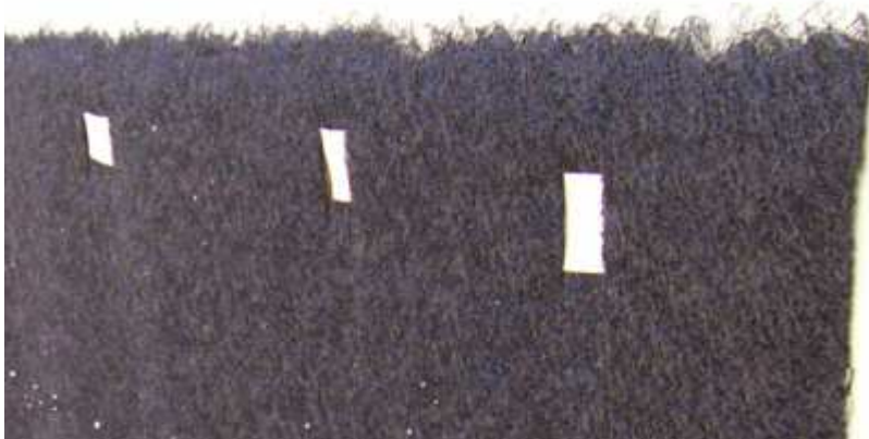
Foto 5. Upevnenie drenážnej vrstvy pomocou pásov z hydroizolačnej fólie na zvislej stene.
