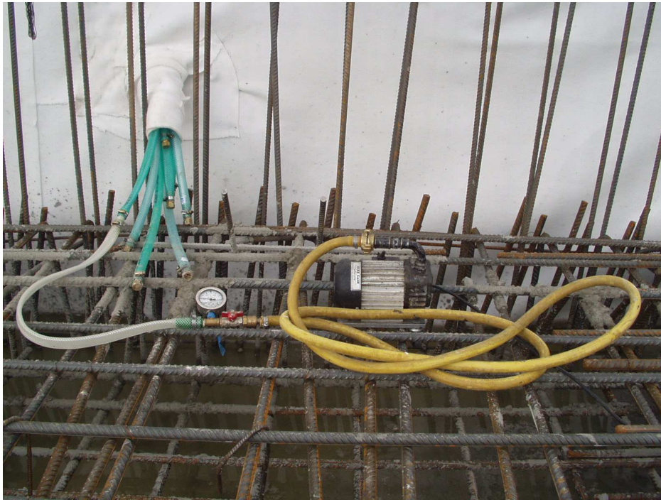
Foto 10. Kontrola tesnosti sektorovej hydroizolácie po vyviazaní výztuže.
