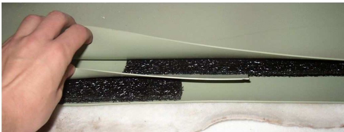
Foto 1. Presah sektorov pre kontrolu spojov
